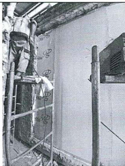
Mẫu thi công hoàn thiện
